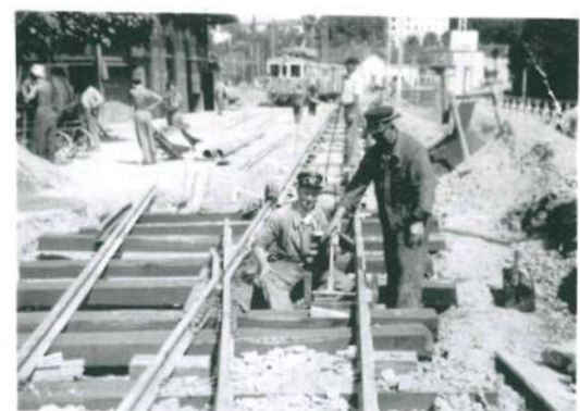
Lavori di manutenzione
